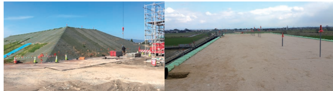
施工後1年経過の路体及び天端状況
