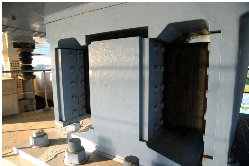
ゴム支承自体には損傷確認できず
