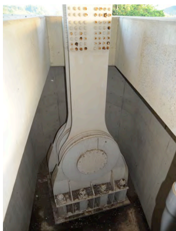
ゴム支承自体には損傷確認できず
