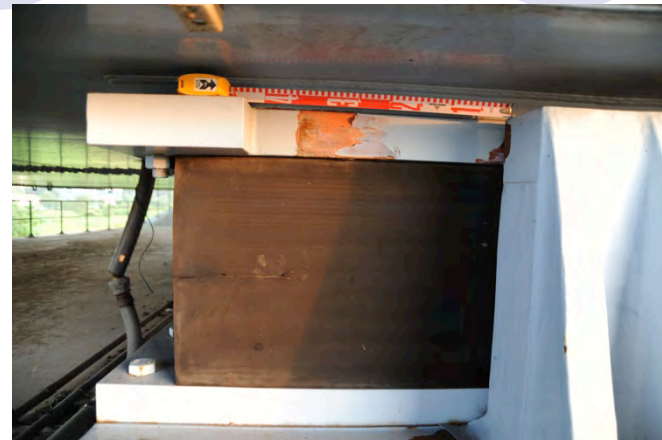
橋軸直角方向側面(川下側)
