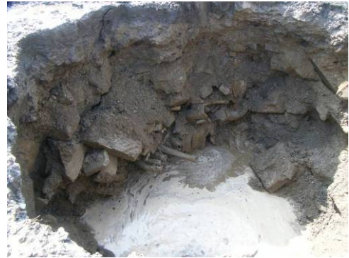
写真-1 掘削時に遭遇した廃棄物
