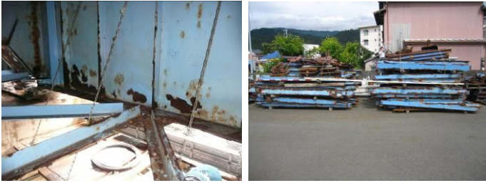
写真-3 試験体として利用した海岸沿い橋梁の下横構 (左: 撤去前の現橋, 右: 撤去後の廃材)
