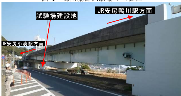
写真-1 試験場(坂下高架橋)の全景写真
