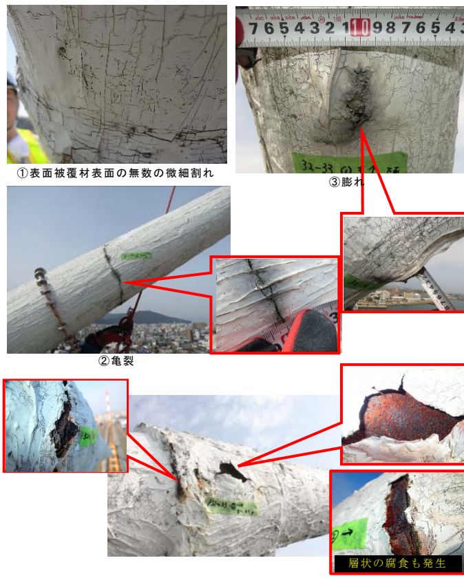
写真-2 ケーブル部の現況写真
