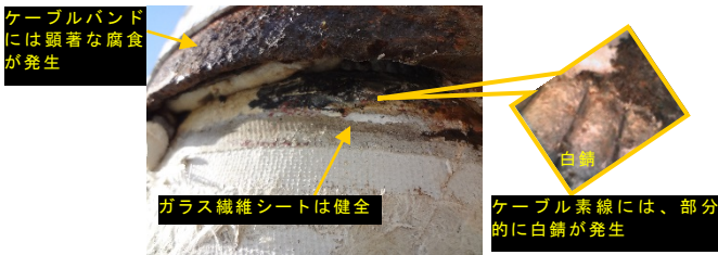
写真-7 ケーブルバンド部の内部状況
