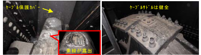
写真-3 塔内ケーブル定着部の現況写真
