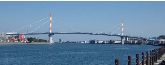
写真-1 末広大橋の全景写真
