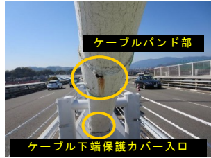
写真-6 詳細調査箇所
