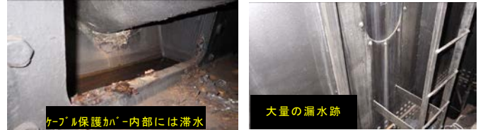
写真-4 塔内漏水、滞水の状況写真
