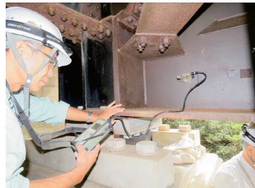
写真-2 RSTによる計測状況
