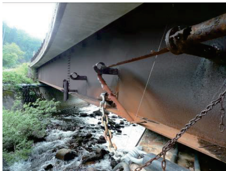
写真-1 排水装置の破損による異常さびの例
