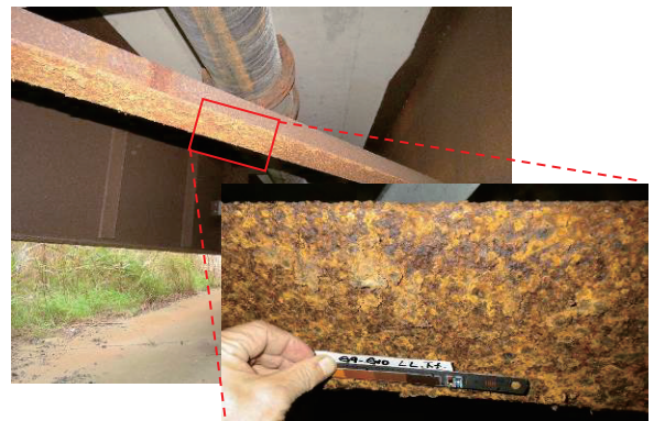
写真-3 異常さびの発生状況
