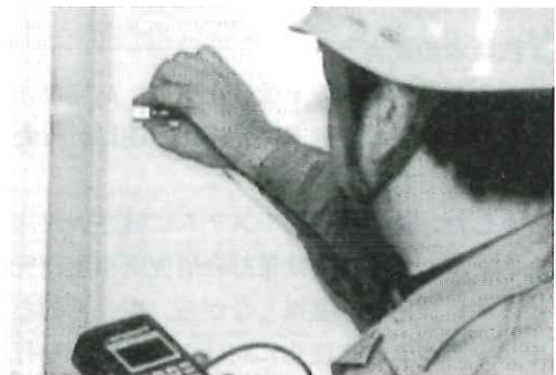
写真-1 鋼部材溶接部の超音波探傷試験
