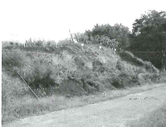
写真-7 施工後6ヶ月
