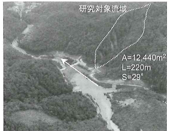
写真-1 荒谷右支川の空中写真 (平成11年6月30日撮影)
