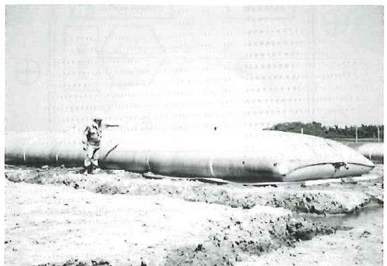
写真-1 袋詰脱水処理工法(エコチューブ)
