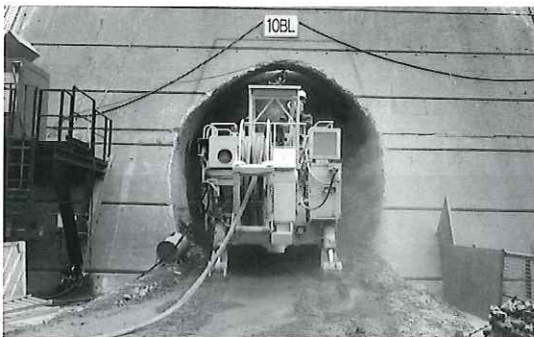
写真-1 既設ダム堤体の削孔状況 (五十里ダム)
