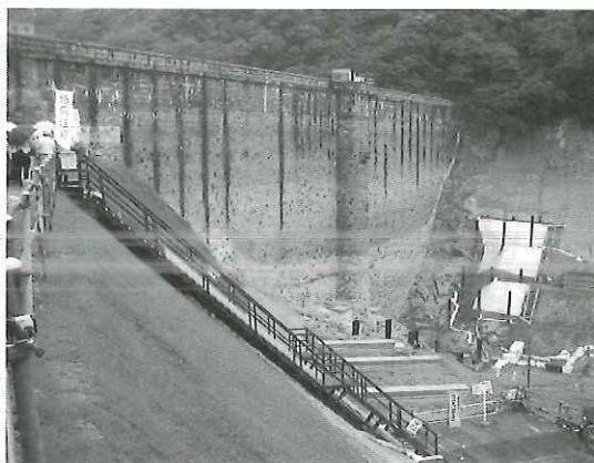
図-2 耐震補強工事中の布引ダム上流面 (2003年6月27日撮影)
