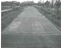
写真-4 工法Cの施工状況
