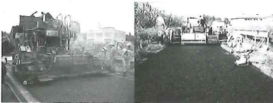
写真-2 工法Aの施工状況
