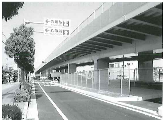
写真-2 原田高架橋近景
