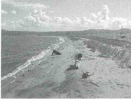
写真-5 宍道湖、斐伊川河口左岸。施工後、斐伊川からの土砂供給もあり、より自然な形状に変化。
