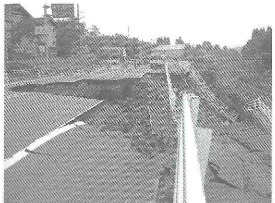
写真-1 国道117号小千谷市塩殿
