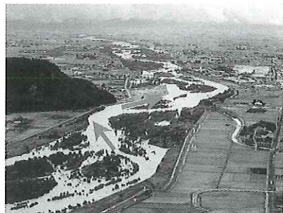
写真-2 樹木群による河岸侵食の誘発 (阿賀野川水系 阿賀川)
