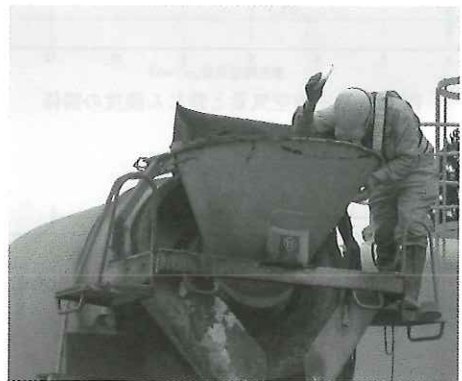
写真-1 袋詰粉じん低減剤の投入状況
