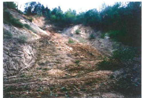
写真-2 ブザウサブカルパチアン地域の深層地すべり (コンスタンチン2004)
