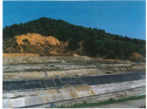
写真-3 芋川流域の深層地すべり (東竹沢地すべり)
