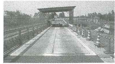
写真-2 リサイクル舗装材料耐久性試験施設
