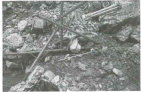
写真-3 濁度計の堆砂状況
