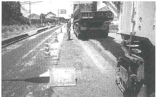
写真-3 切削工法
