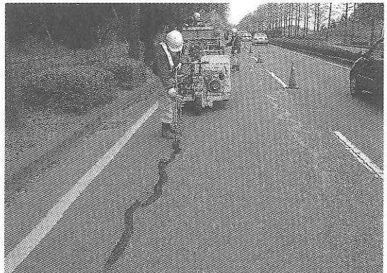
写真-2 シール材注入工法
