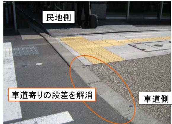
写真-1 車道寄りの段差を解消した例(国道7号新潟駅前)
