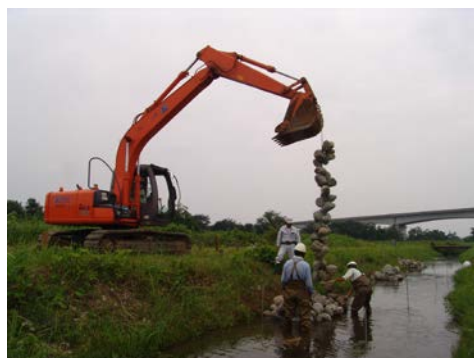
写真-3 礫群設置方法
