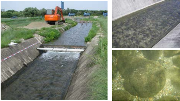
写真-3 土砂供給実験の状況
