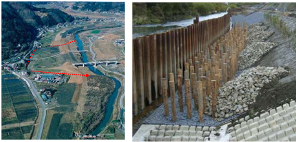
写真-2 砂鉄川直線化と導入した修復工法
