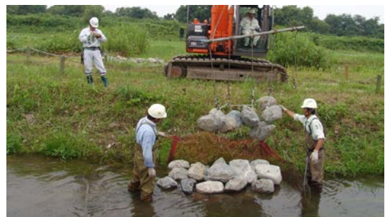
写真-1 石礫群の吊り上げ実験の様子
