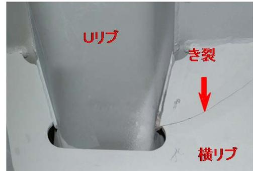
写真-2 道路橋鋼床版に発生した疲労き裂の例
