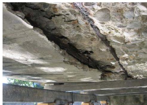
写真-1 塩害により損傷した橋梁
