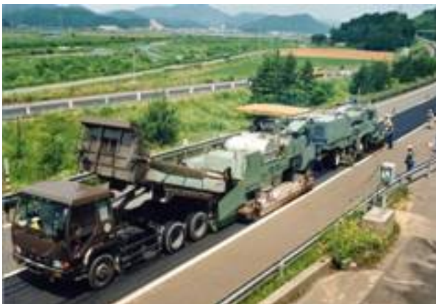
写真-2 路上表層再生工法
