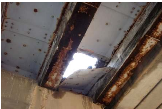
写真-2 鋼板接着補強されたRC床版の抜け落ち
