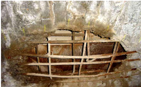
写真-1 RC床版の抜け落ち(上:抜け落ち5日前、中:抜け落ち直後の路面、下:鋼板による応急処置後の床版下面)
