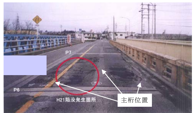
写真-8 RC橋(3主桁)の橋面舗装の劣化事例
