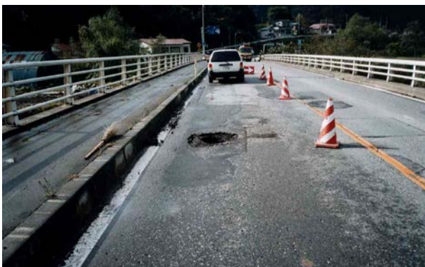
写真-6 床版抜け落ち部周囲の路面状態 6)
