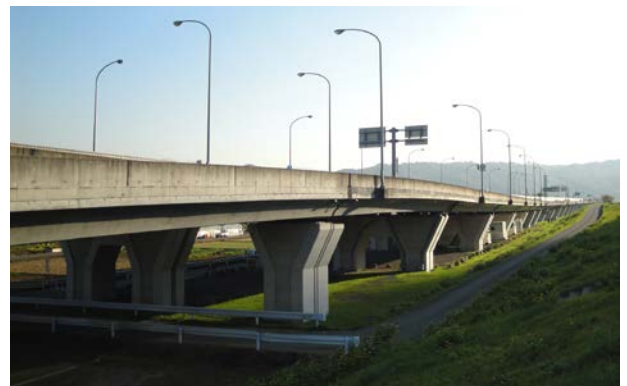
写真-1 対象免震橋の全景
