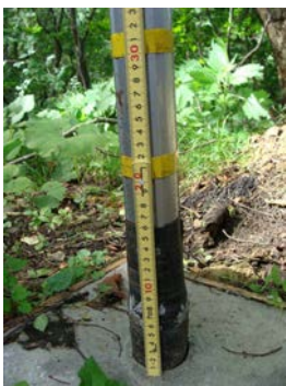
写真-3 H20B-3孔の孔口浮き上がり測定状況
