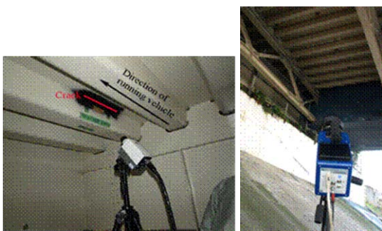
図-5 赤外線サーモグラフィによる計測状況 (左：近接、右：遠隔)
