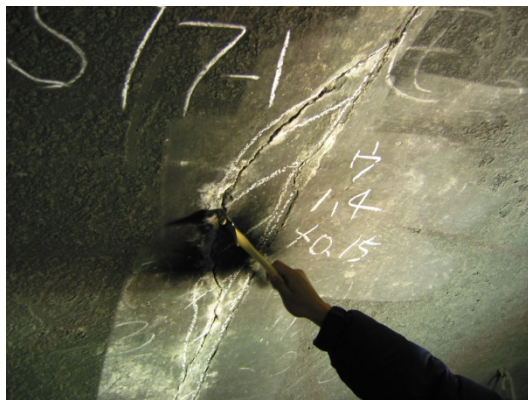
写真-2 型枠押し上げによるひび割れの例
