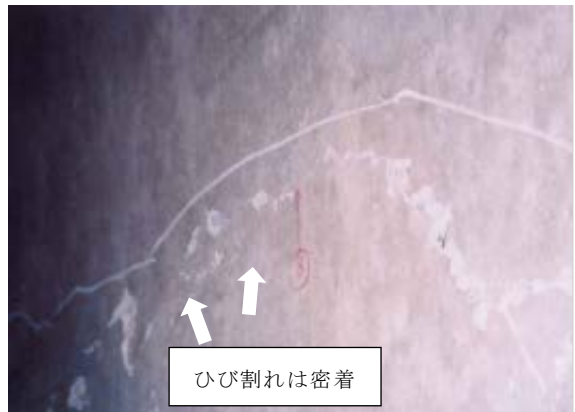
写真-4 せん断によるひび割れの例
