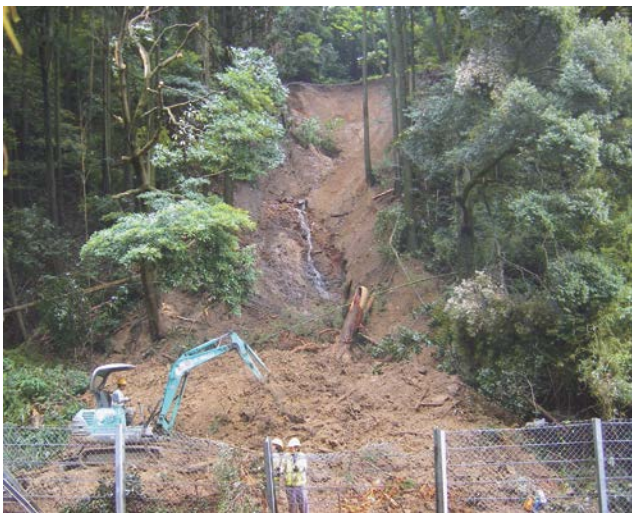
写真-5 集中豪雨による自然斜面の崩壊事例 (管轄事務所提供)
