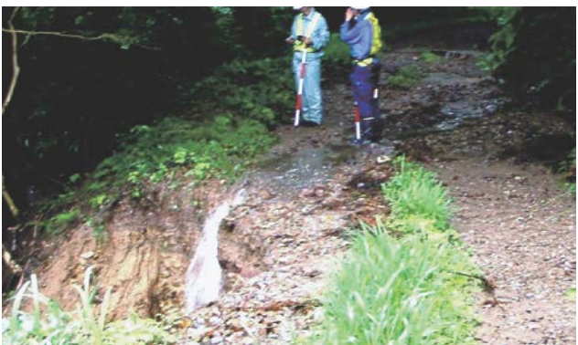
写真-6 斜面上方の旧道からの表流水の流入 (管轄事務所提供)
