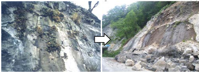
写真-9 亀裂が多数発達していたモルタル吹付工の崩壊事例（管轄事務所提供）
