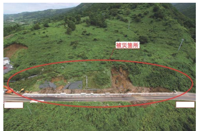
写真-3 海岸段丘堆積物からなる切土のり面の崩壊事例（管轄事務所提供）
