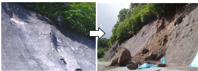
写真-10 吹付のり面凸部の崩壊事例（管轄事務所提供）
