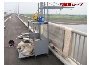
図-3 移動式観測架台
