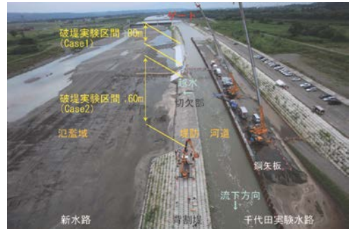
図-1 千代田実験水路における実験状況
