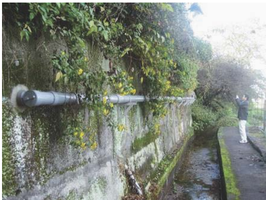
写真-1 クイック配管（露出配管）
