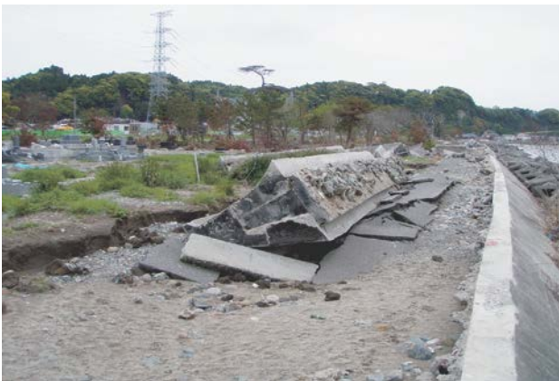
写真-7 直立堤倒壊 (植田岩間海岸)
