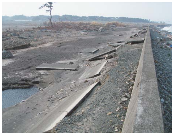
写真-6 裏法天端の被災と背後の洗掘溝 (南海老海岸)
