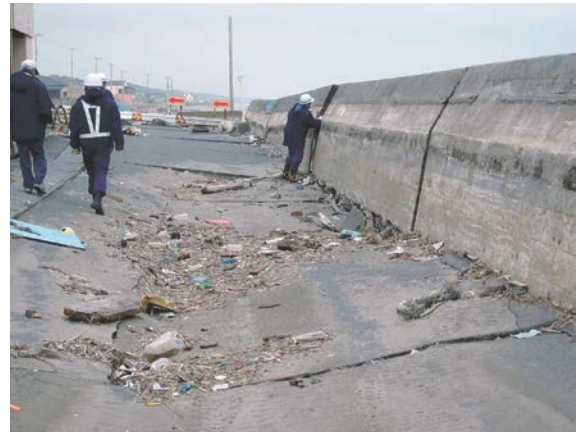
写真-9 天端保護工陥没 (鉾田海岸)
