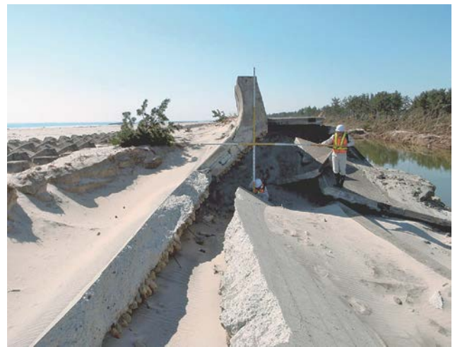
写真-4(b) 堤防表法被覆工被災(吉田浜)
