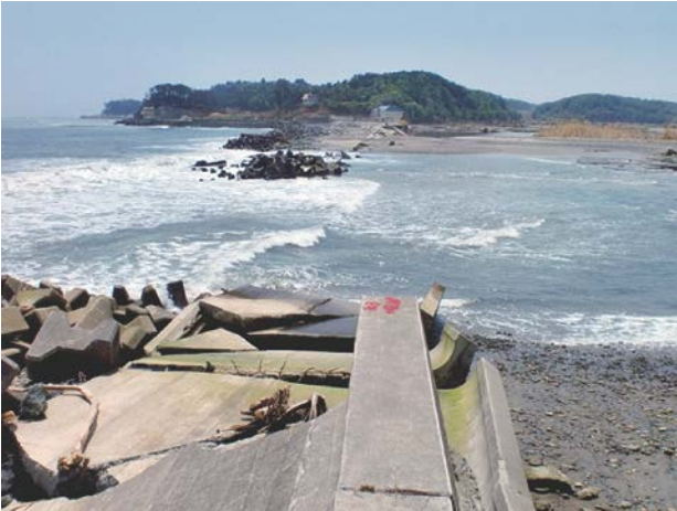
写真-5 破堤全壊と海岸線後退 (古磯部地先海岸)
