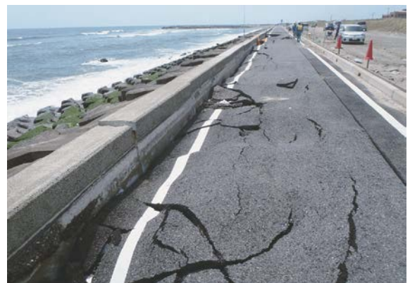
写真-10 護岸天端被災 (野手海岸)
