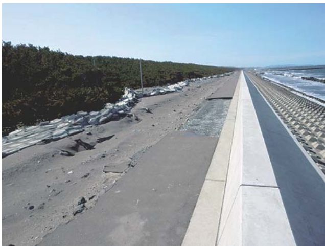
写真-1 裏法被覆工の流失（一川目地区海岸）
