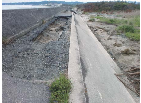
写真-8 堤防天端保護工被災 (須賀地区海岸)
