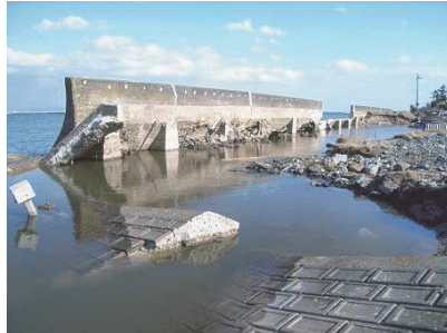
写真-3 特殊堤の破堤 (鳴瀬川)
