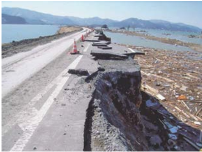
写真-5 越水による侵食・落堀 (新北上川)
