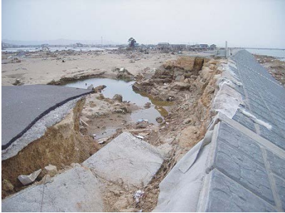
写真-2 越水による侵食・落堀 (阿武隈川)
