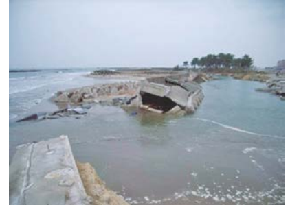
写真-4 海岸堤防との接合部での破堤 (阿武隈川)
