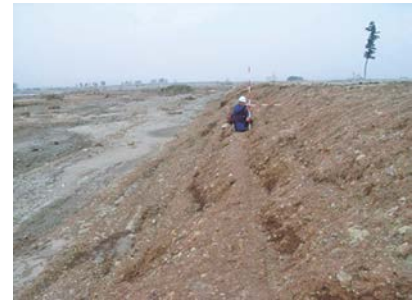
写真-7 遡上流による植生剥離・侵食 (名取川)
