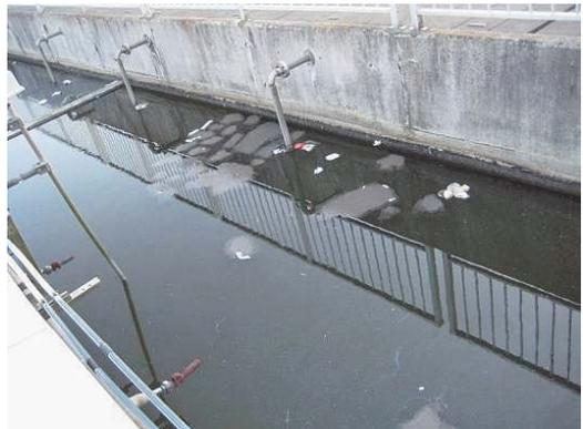
写真-4 活性汚泥の死滅(相馬市下水処理場)
