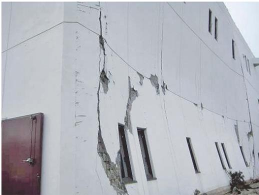
写真-1 圧力による壁の変形(南蒲生浄化センター)
