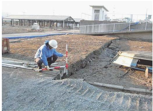
写真-3 処理場内での地盤沈下(相馬市下水処理場)
