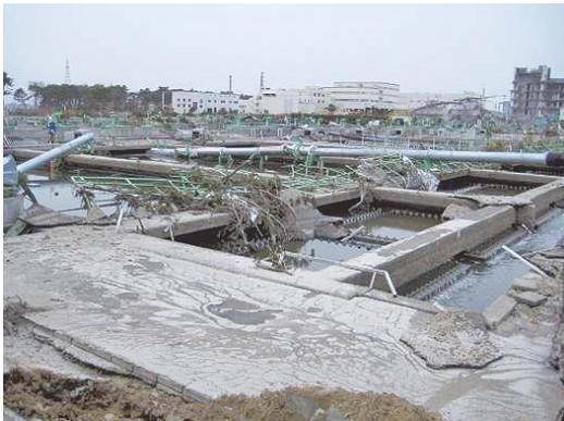
写真-2 漂着物による施設破損(南蒲生浄化センター)
