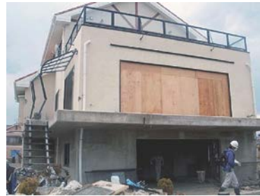
写真-16 1階RC構造の例
