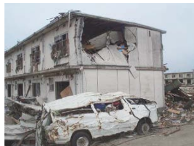
写真-6 漂流物の衝突による壁脱落
