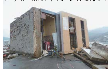
写真-2 3階建て建築物の転倒
