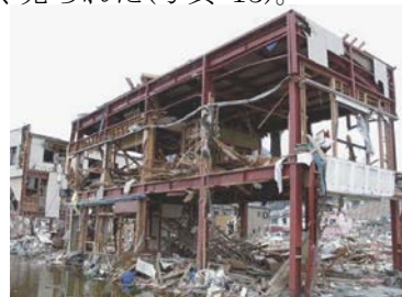
写真-13 残存する2階建てS造
