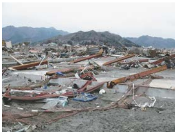
写真-8 1階柱がなびくように残存
