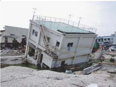
写真-4 洗掘による2階建て建築物の傾斜
