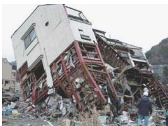
写真-9 3階建てS造の1階の崩壊
