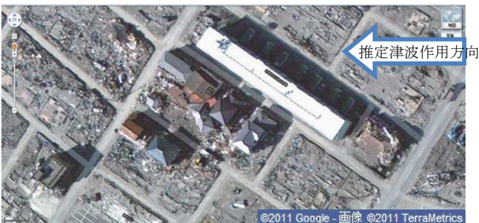
写真-15 残存建築物の背後の残存例
