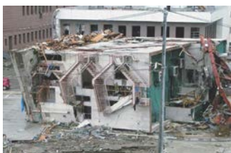
写真-10 3階建てS造の転倒
