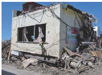
写真-1 2階建て建築物の層崩壊
