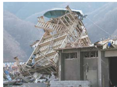
写真-7 柱脚部アンカーボルトの破断により転倒・移動したと思われる建築物
