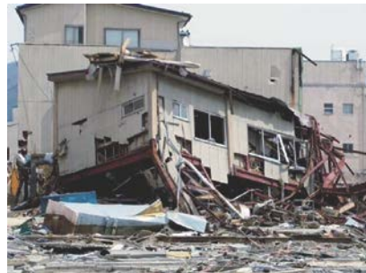
写真-11 2階建てS造の1階の崩壊
