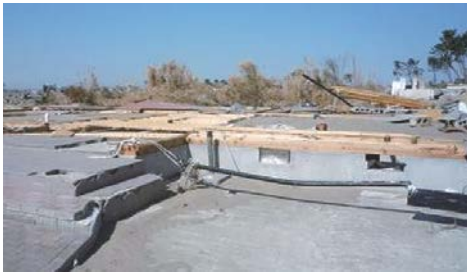
写真-14 上部構造が流失し土台が残った例
