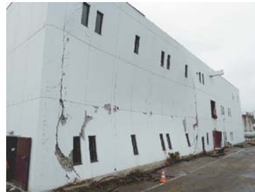
写真-5 床を持たない連層壁の面外破壊
