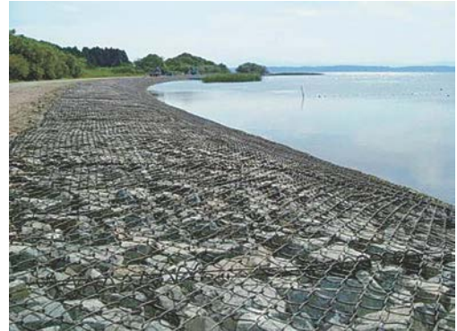
図-2 合成樹脂被覆鉄線の鉄線籠への適用例
