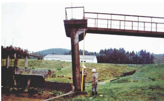
写真-1 阿久戸排水樋管の被災状況 2)
