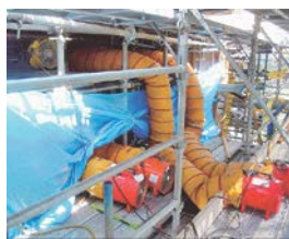
写真-1 エアクーリング実施状況
