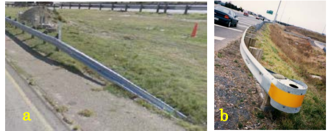
a. すりつけ構造 （ガードレール） b. 緩衝構造 （ガードレール） c. すりつけ構造 （ガードケーブル）
