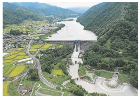
写真-1 土砂バイパスからの放流される濁水 三峰川総合開発事務所パンフレットより抜粋
