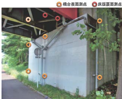
図-7 実橋におけるコンクリート表面温湿度の長期観測
