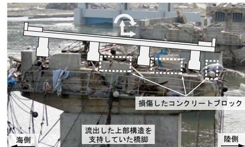
図-2 裏返し状態となつた上部構造の流出挙動イメージ図
