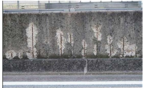
写真-2 対象とした壁高欄の劣化状況
