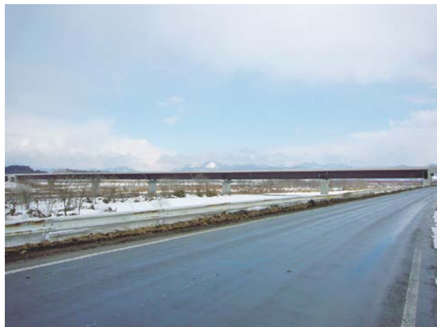
写真-7 真中大橋の架橋状況
