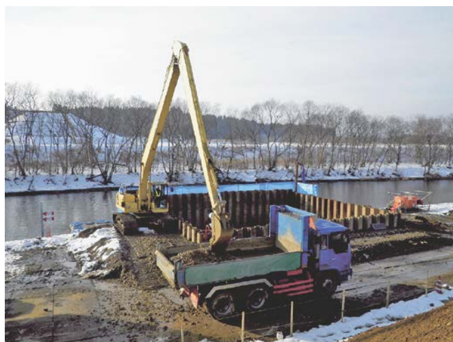
写真-4 橋梁下部工工事の仮締切り状況
