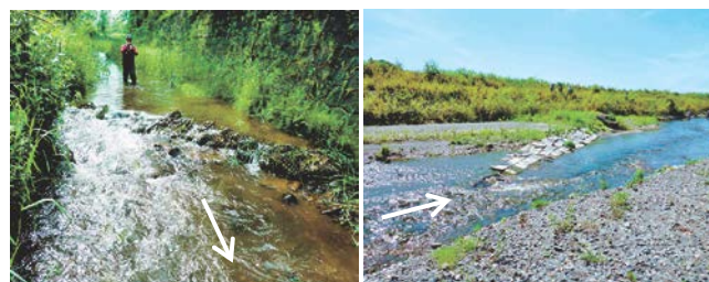
写真-1 バーブ工の施工事例 (左：精進川放水路，右：日高門別川)
